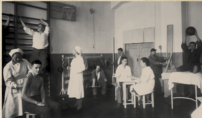
Кабинет механотерапии в эвакогоспитале № 1239
